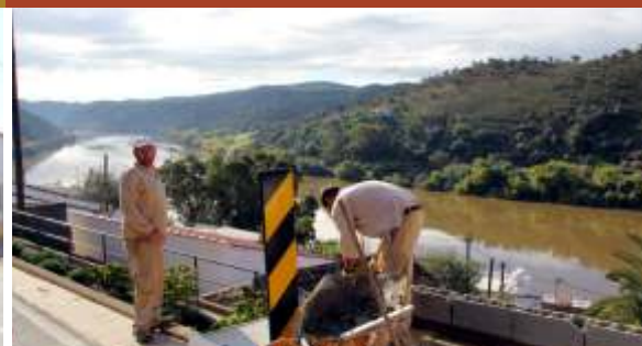
Recuperação de muros de suporte no Pomarão
