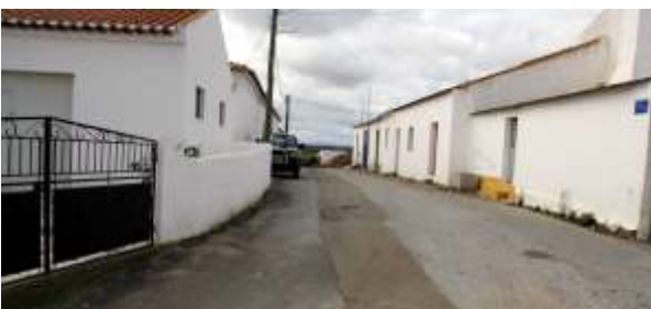
Construção de conduta em S. Pedro de Sólis
