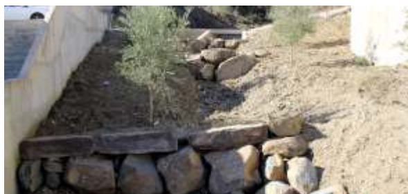
Construção de canal de drenagem na encosta noroeste em Mértola
