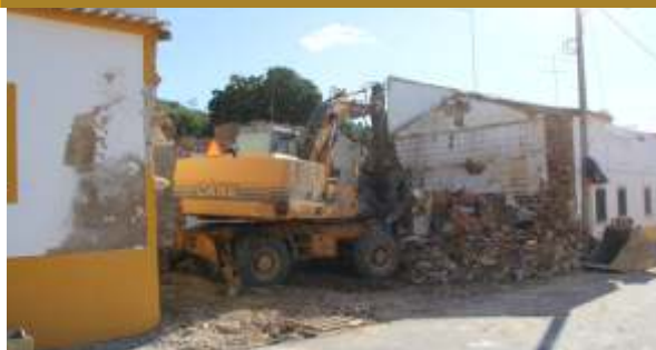
Demolição de casa em Além-Rio
