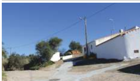
Rede de Esgotos em S. Sebastião dos Carros
