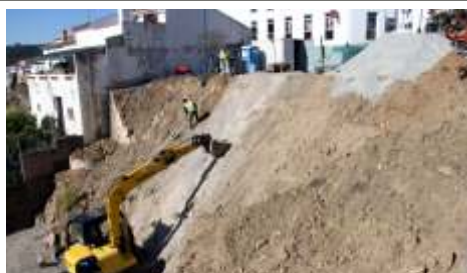
Muro de suporte - acesso à frente ribeirinha
