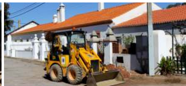
Construção de ramal de água na Mina de São Domingos
