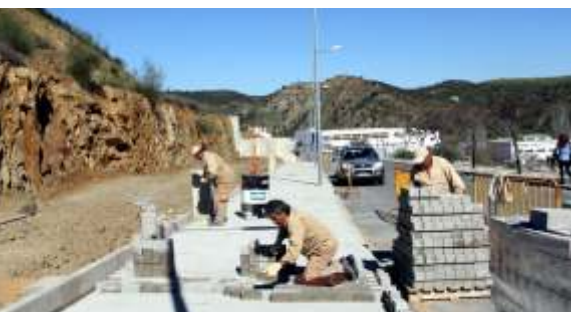
Construções de passeios para a Achada de S. Sebastião (acesso escolas)
