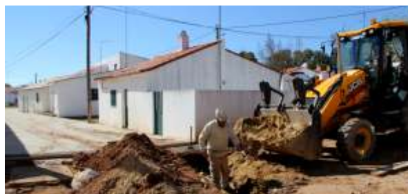
Arruamentos na Mina de São Domingos
