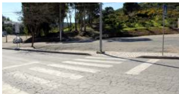
Passagens rebaixadas nas passadeiras da Vila
