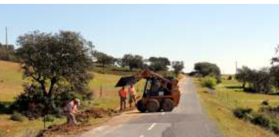
Arranjo da estrada Vale do Pereiro-Corte do Pinto
