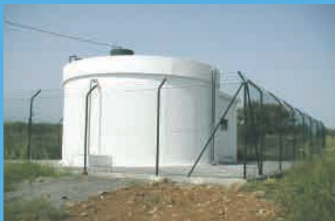
Reservatório S. Pedro de Sólis
