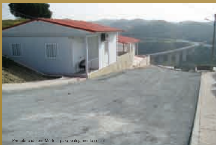
Nova Ze2, com a construção das habitações em curso
