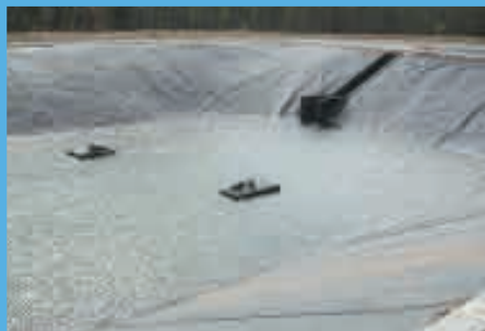
Etar Mina S. Domingos
