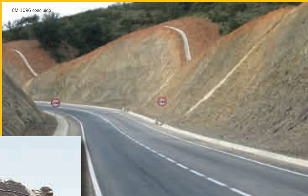
Repavimentação com micro-aglomerado betuminoso
