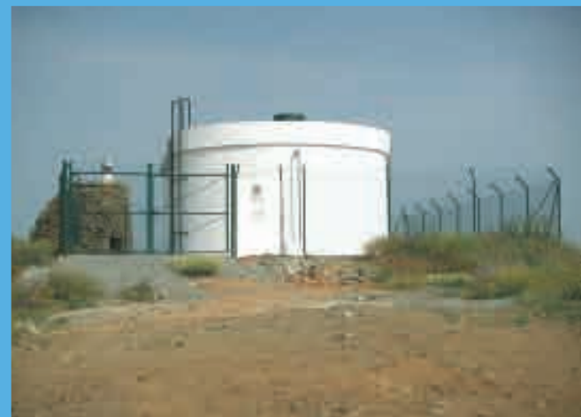
Reservatório São João dos Caldeiros
