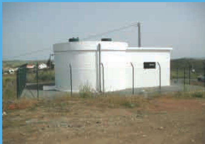
Reservatório S. Miguel do Pinheiro
