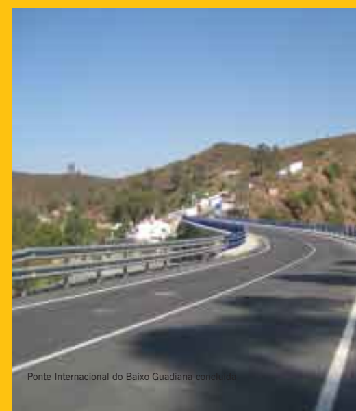
Ponte Internacional do Baixo Guadiana em obra
