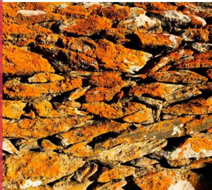
Localmente, enquanto construção de demarcação, são estruturas de alvenaria de pedra de xisto e grauvaque, de assentamento direto da pedra rústica, deitada, com algum aparelhamento, o que resulta num muro compacto, mas quase sempre de aspeto irregular.
