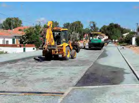
Pavimentação da rua de acesso à praia Mina S. Domingos
