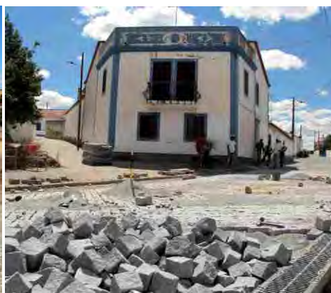
Pavimentação e Arruamentos | Corte Gafo Cima
