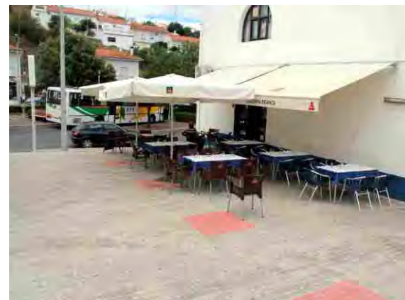
Pavimentação do Largo junto à paragem da rodoviária Mértola
